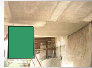
⑦断面修復工完了
