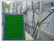
A施設内擁壁
