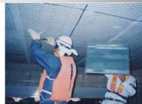
面状陽極材の設置例
