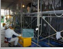
リチウムイオン内部圧入工施工状況
