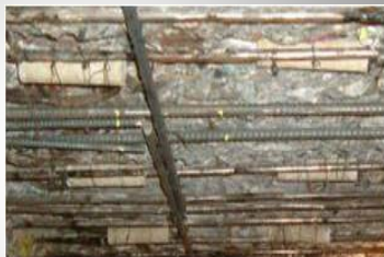
犠牲陽極材の設置状況
