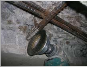
④鉄筋ケレン
