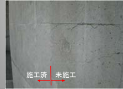
施工境界付近の状況
