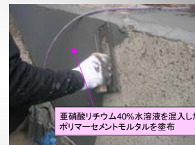
⑨亜硝酸リチウム含有ポリマーセメントモルタル塗布
